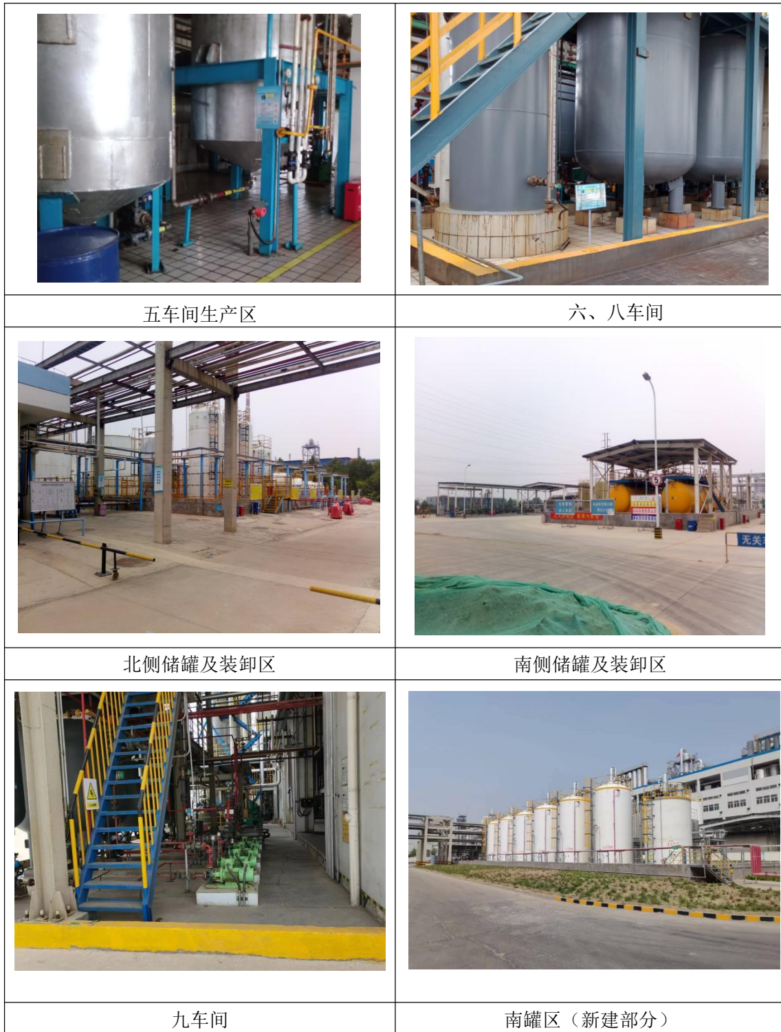
图5.4-1 厂区现状照片
