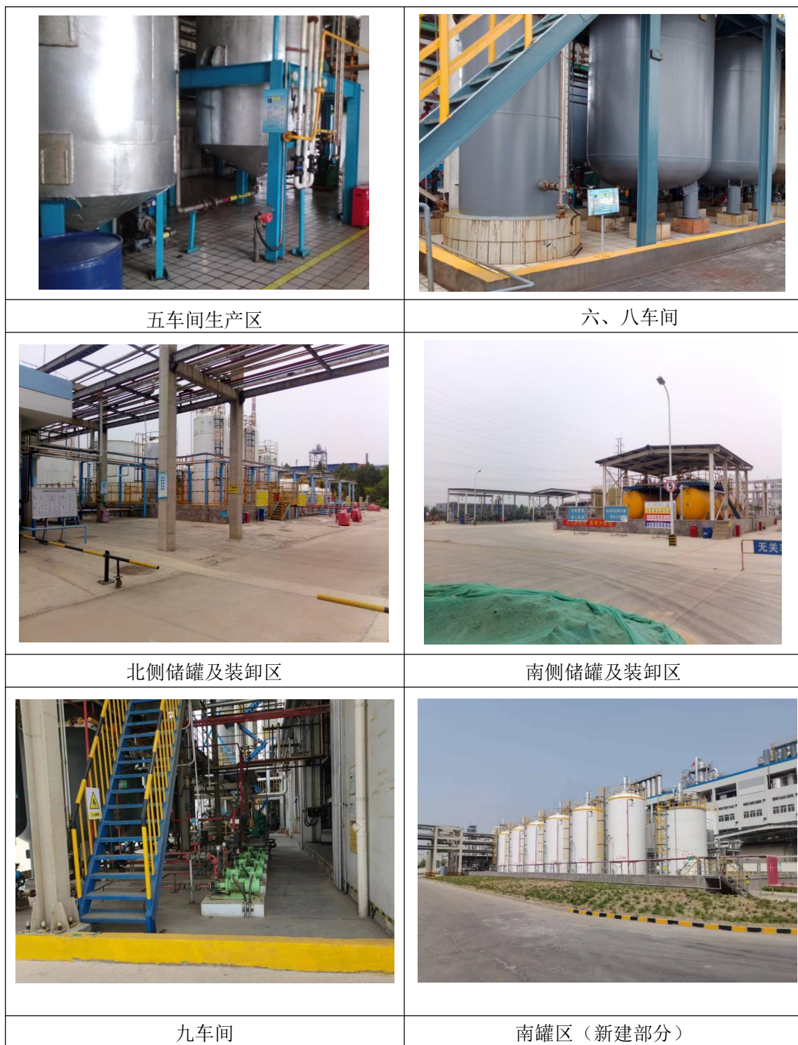
图5.4-1 厂区现状照片
