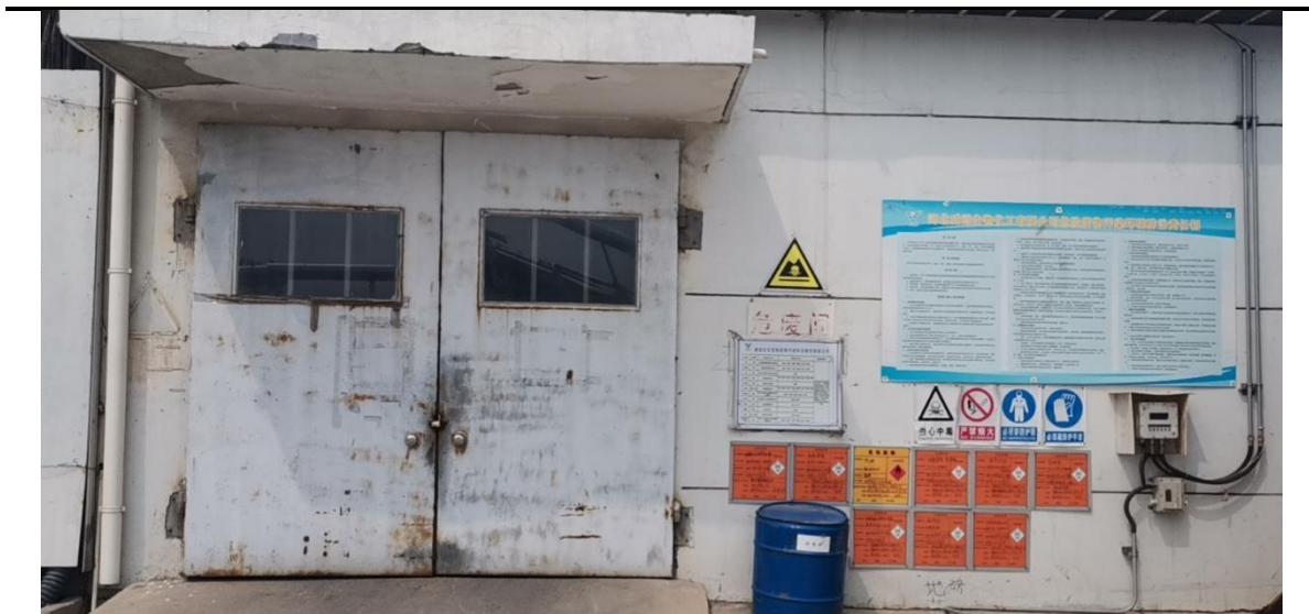
1#危险废物暂存间
