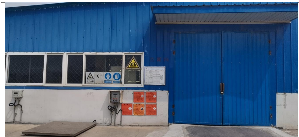
2#危险废物暂存间
